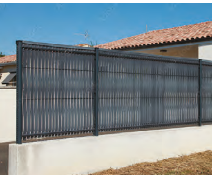
Muret + panneaux PVC, une surélévation peu esthétique
