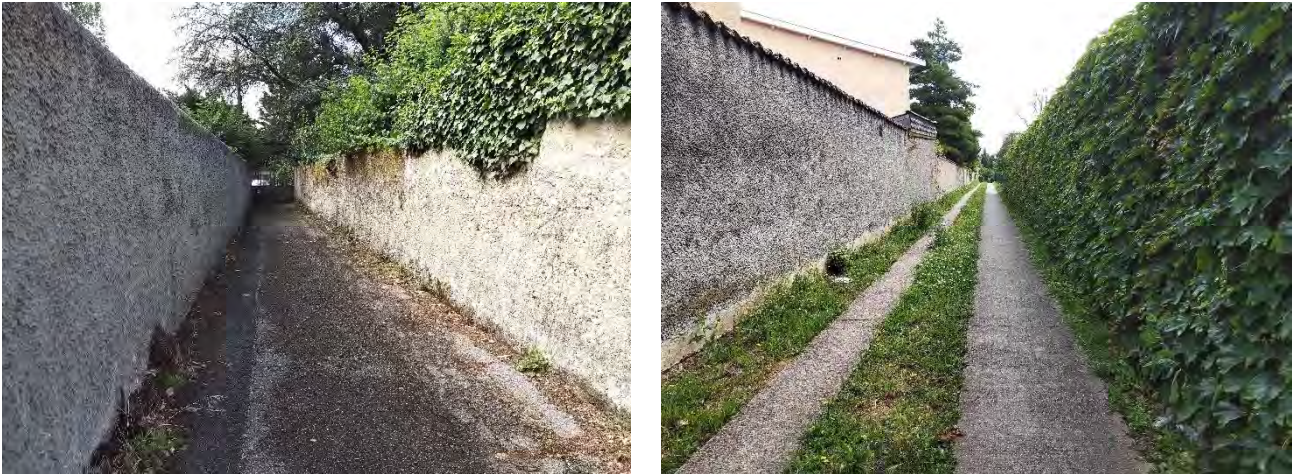
Figure 30 : Limites de propriété et copropriété matérialisées par des murs infranchissables pour la petite faune terrestre au sein de la zone URm n°5 (Biotope, 2021)
