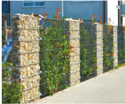
Grillage treillis soudés + mur en gabion : une association intéressante
