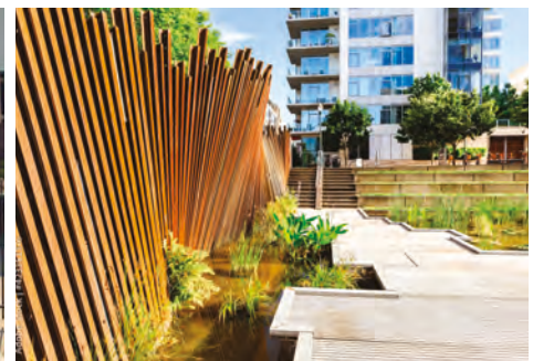
Lames d'acier corten inclinée pour fermer et laisser passer les vues selon certaines orientations
