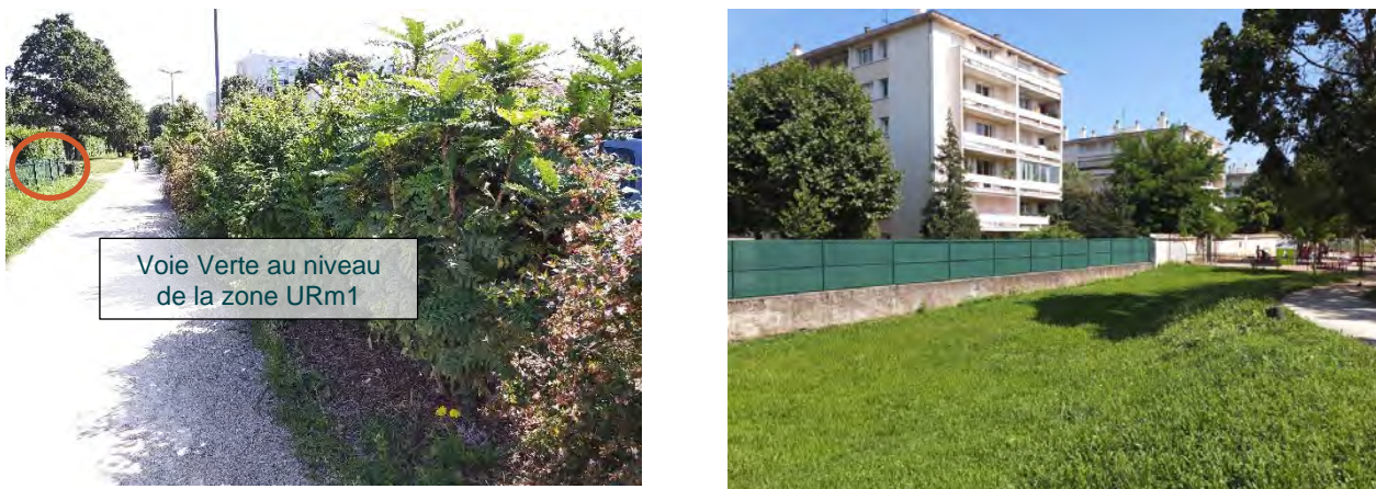
Figure 9 : Malgré quelques ouvertures sur la Voie Verte, une grande partie du linéaire attenant à la zone URm1 est délimité par des séparations difficiles à franchir pour la faune, comme des grillages à mailles fines, parfois soutenues par des murets assez haut (Biotope, 2021)
